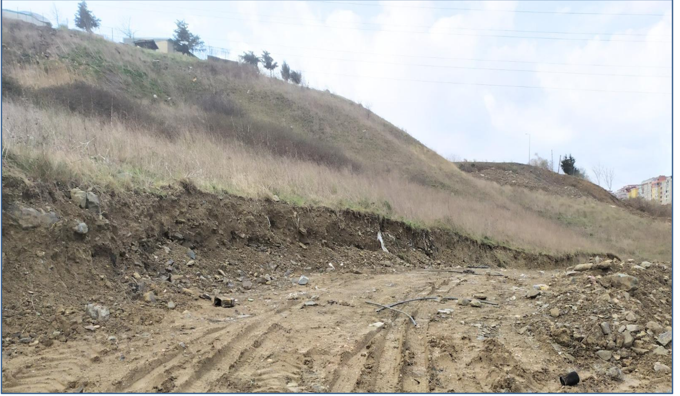
İnceleme alanının güney sınırında bulunan kalın kontrolsüz dolgu tepeleri
