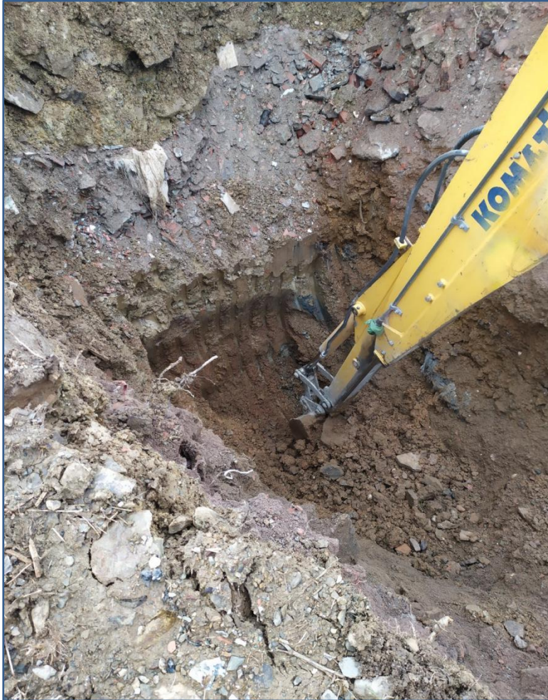
B Blok batı köşesinde yapılan araştırma çukuru
